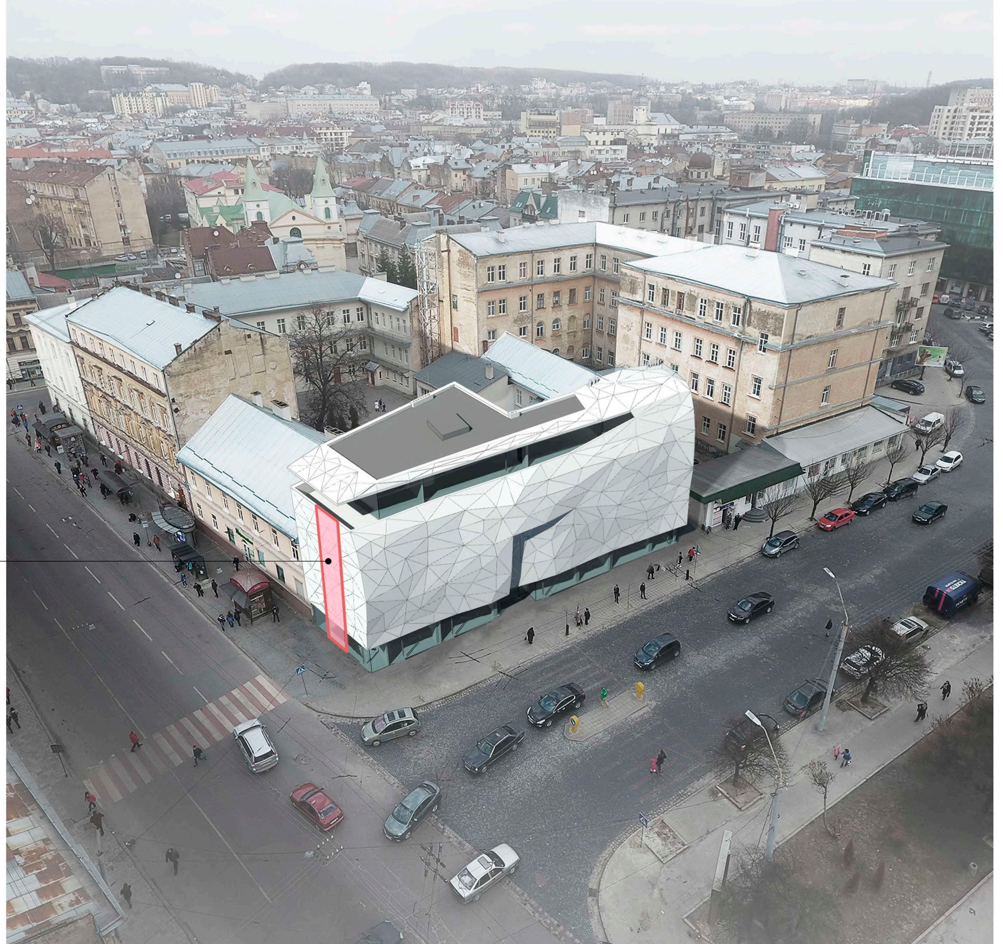
Фрагмент навісного фасаду для захисту від надмірної інсоляції та перегріву приміщень
